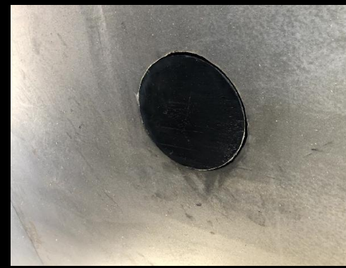
3、打設口閉(打設終了)
