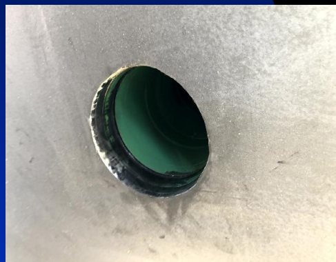
1、打設口開(打設前)
